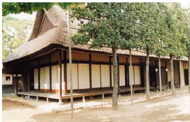
←2辺にわたってつけられている縁側 (国立市古民家)
