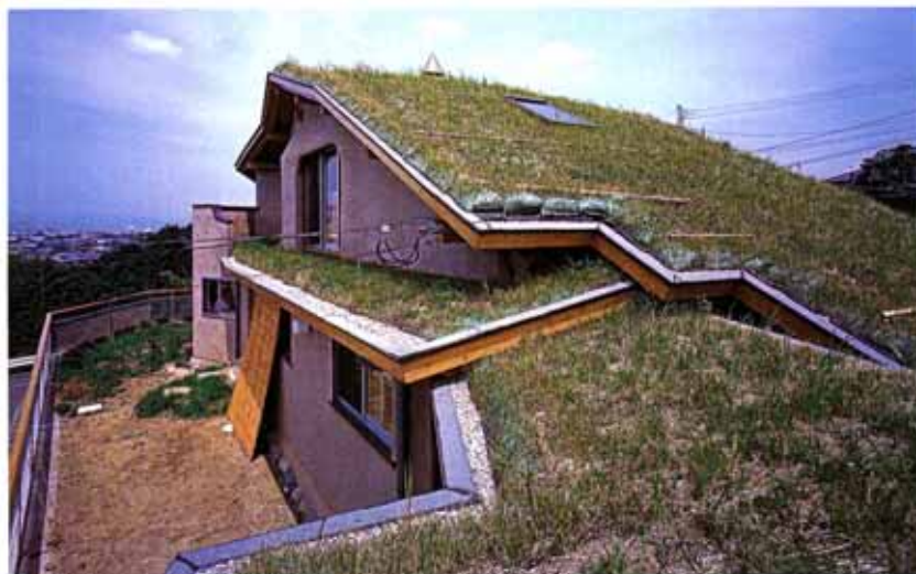
写真制から屋根緑化を見る。メンテナンスのために、ガラス板に屋根にすてられるようにしてある
